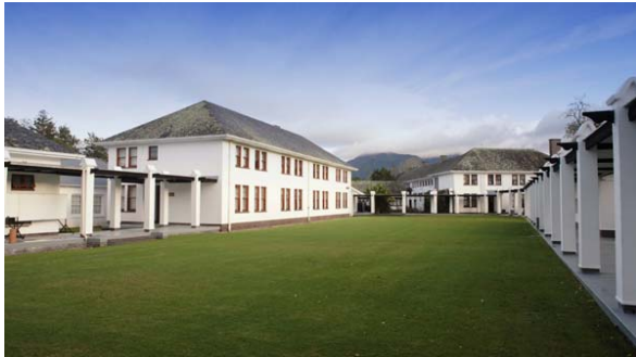
Saasveld Campus, Unterrichtsgebäude
